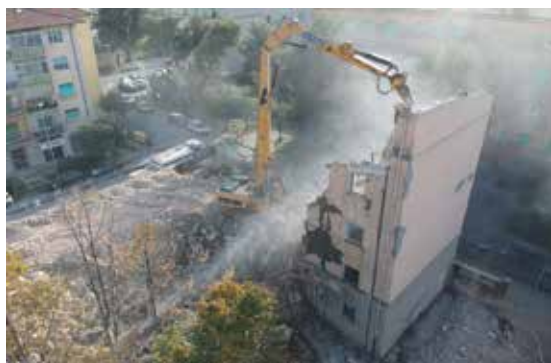
Demolizione edificio "La Chiccaia" Casalp Livorno
