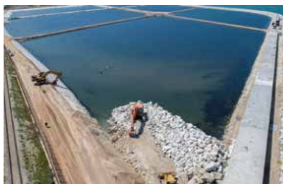
Riempimento per realizzazione di vasca di colmata. Porto di Livorno.
