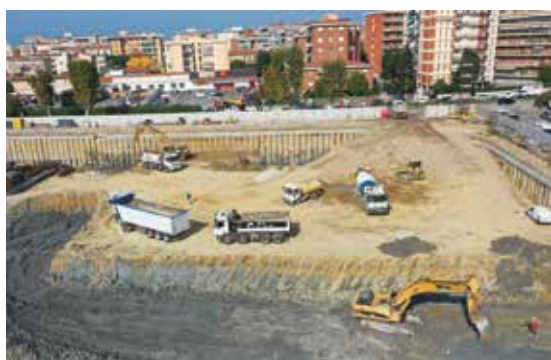
Scavo di sbancamento per realizzazione fondazione di Centro Commerciale Esselunga - Sa.Fer S.p.a. - Livorno.
